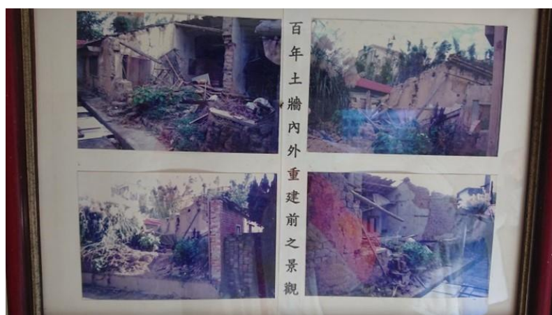
圖 4 公廳新起之前个泥磚屋塌角陋少情形 （2023. 11. 07 翻拍自虎片橫屋个壁項）
