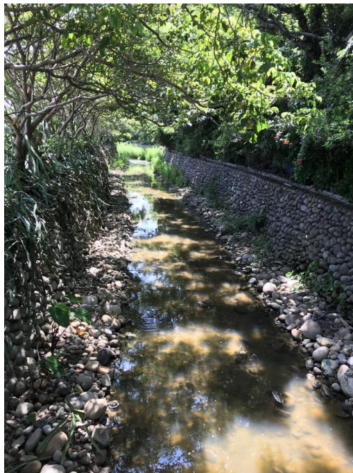
[圖 14.3] 經生態工法整治个三七圳新屋段
