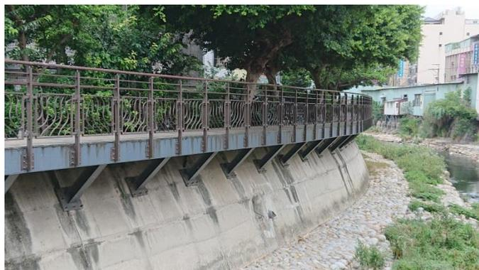
圖 6 用鋼架探出河壩駁做個行廊，整治過後个新街溪河壩（2021.06.22 攝，地點：健行橋南側）
