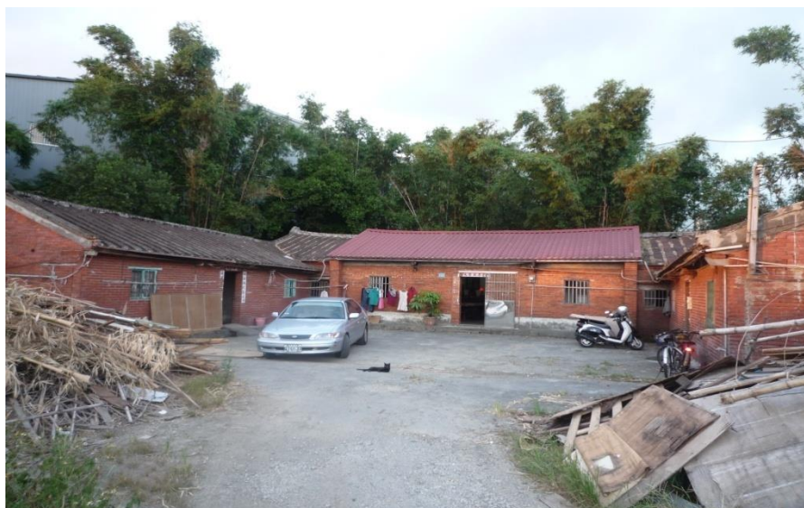
（圖 1：上南勢南天橋徐俊玉派下老屋，正身屋頂已改成鐵皮。）
