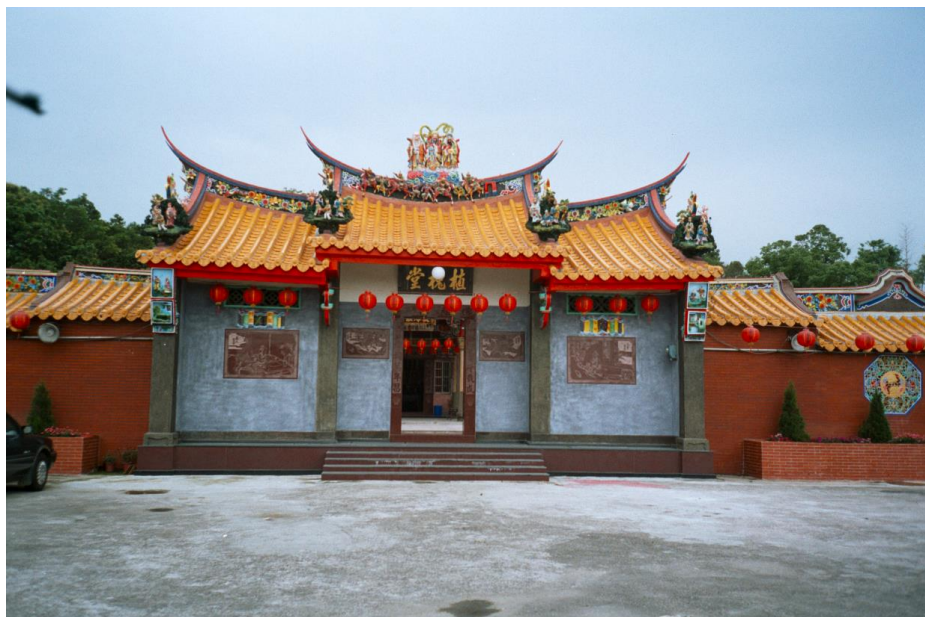
(圖 2：93 年 12 月修建完成後平鎮植槐堂門樓外觀，攝於 94.5。)
