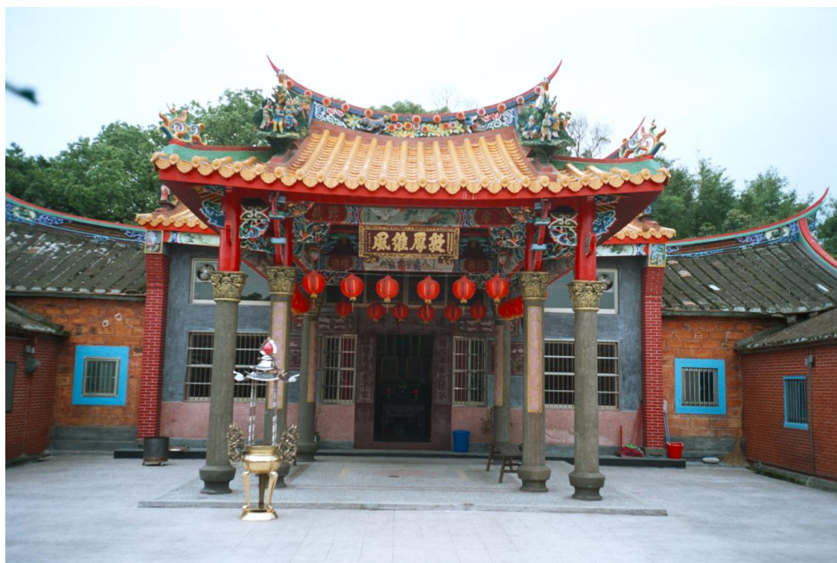
(圖 3：93 年 12 月修建完成後平鎮植槐堂正廳前掛等「敦厚維風」个橫匾，攝於 94.5。)
