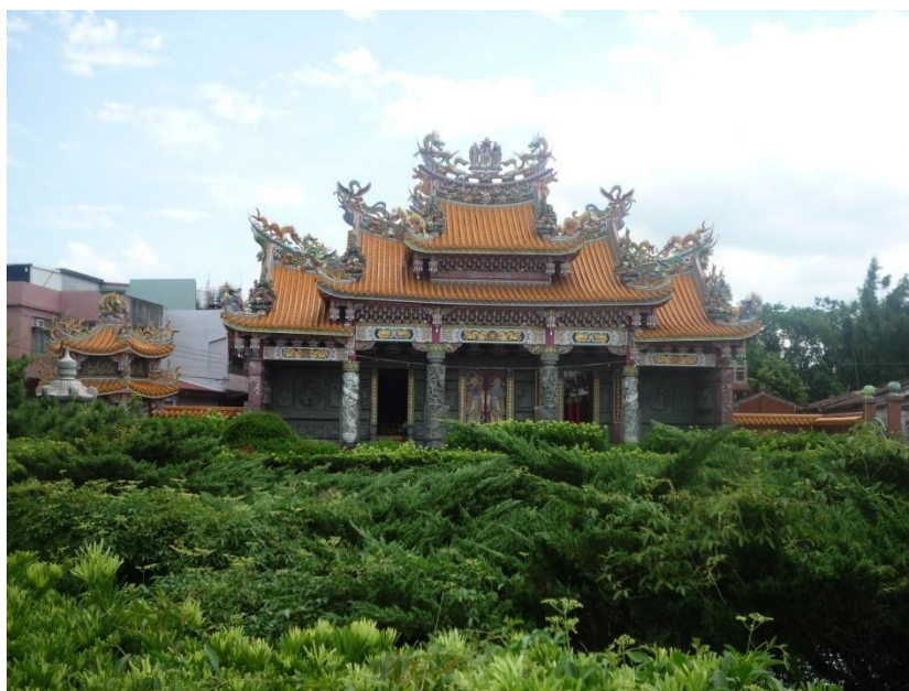
(圖 2：民國 89 年新建完成个葉奕明公祠 101.08.25)
