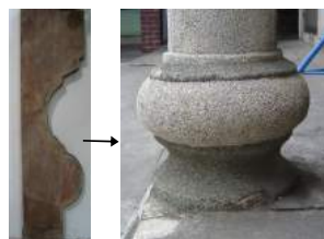
圖七：圓墩柱腳製作模型 （鍾水勤匠師提供）
