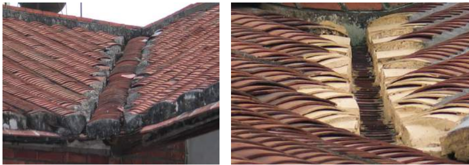
圖三：轉溝—雙溝形式（傅辛發匠師所建） 轉溝—單溝形式（李榮貴匠師所建）
